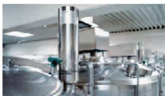
Carcaças de filtro para aeração em tanques de armazenamento
